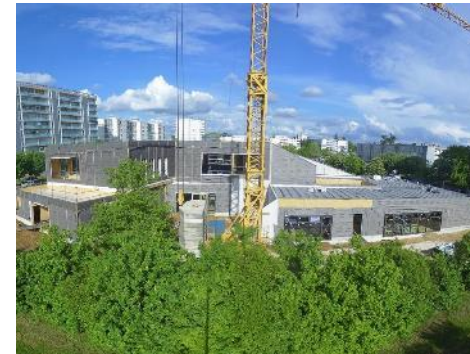
Travaux dans le cadre du renouvellement urbain (2,8 M€)
