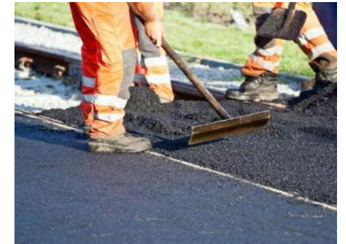
Travaux de voirie (1,1 M€)
