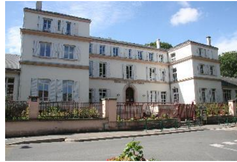
Ecole Cours Tarbé 131 K€ : réfection des sanitaires, réfection des salle de classe et du mur d'enceinte
