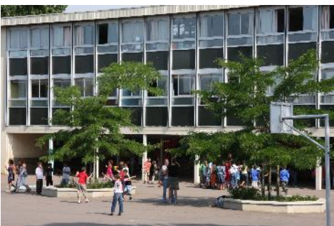
Ecole Paul Bert 241 k€ : travaux désamiantage et menuiserie, réfection des sanitaires
