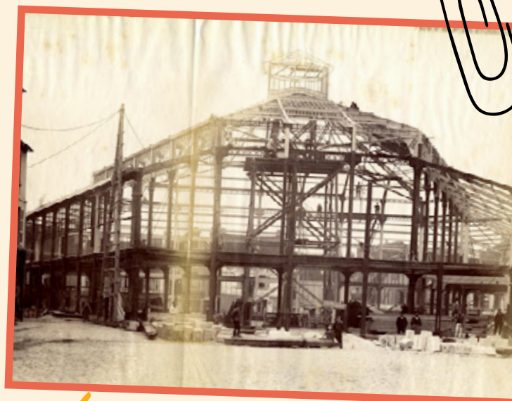
Notre marché couvert en construction !
